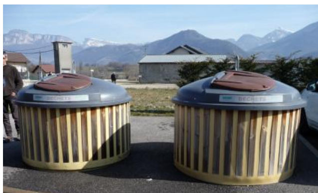
Conteneurs semi-enterrés à Chacuzard
